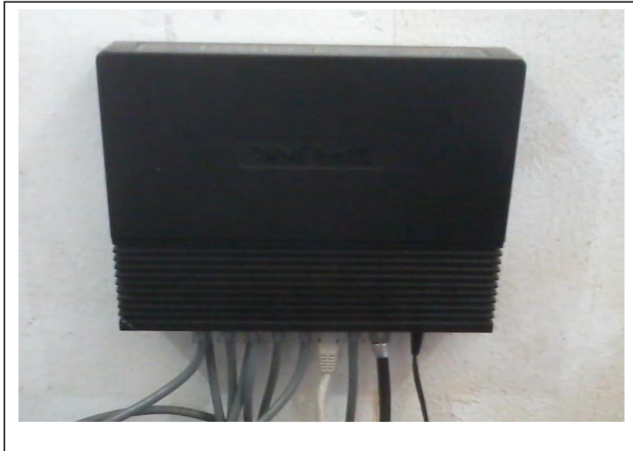
Gambar 3.54 Foto Switch Hub saat penggantian kabel STP jaringan LAN di Kantor DPPKAD
