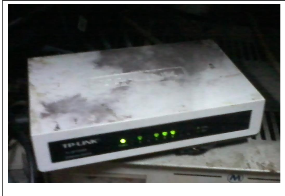
Gambar 3.44 Foto Perbaikan Jaringan di KantorPembkab Bantul Bag. Protokol
